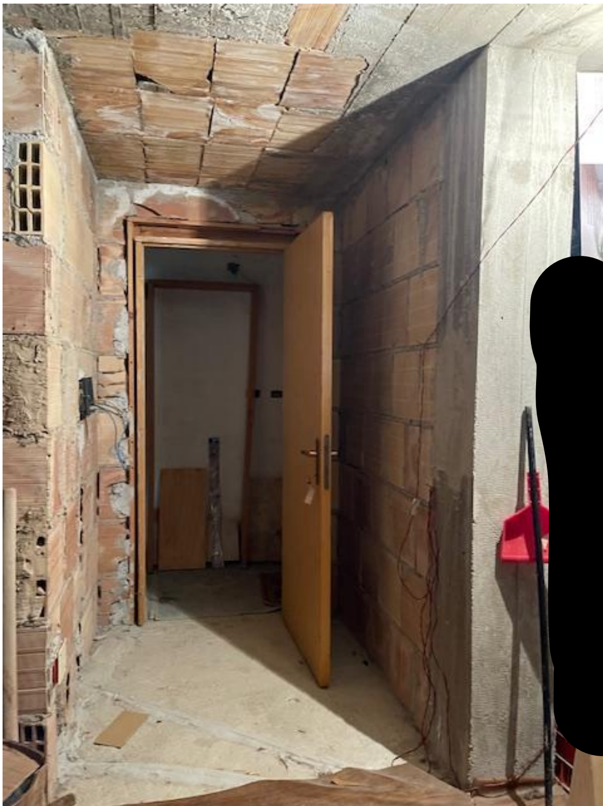
vista dell'ingresso al locale sottotetto
